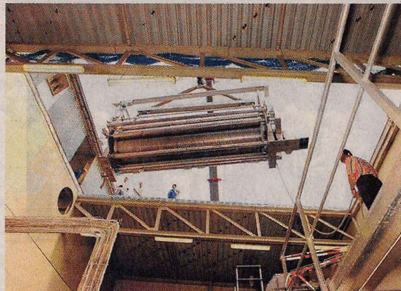
Ganz langsam senkt sich der 35-Tonner durch das knapp bemessene Loch im Hallendach – zum Glück, ohne dabei anzuecken.
