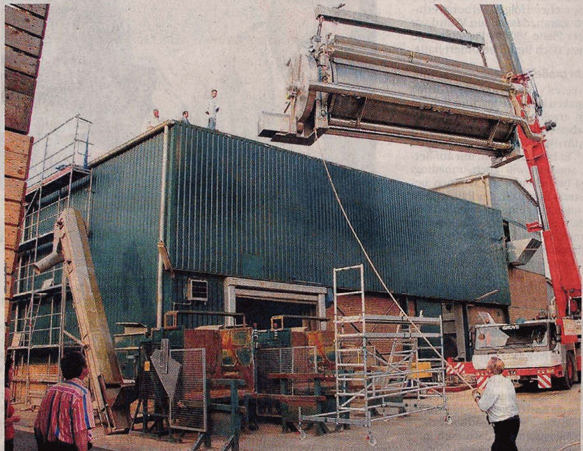
Millimeterarbeit: Ein 300 Tonnen schwerer Kran hievt den neuen Kartoffel-Walzentrockner der Firma Nähr-Engel in die Produktionshalle. Auf dem Dach koordiniert Stefan van den Boom den Ablauf. RP-FOTOS (2): GOTTFRIED EVERS
